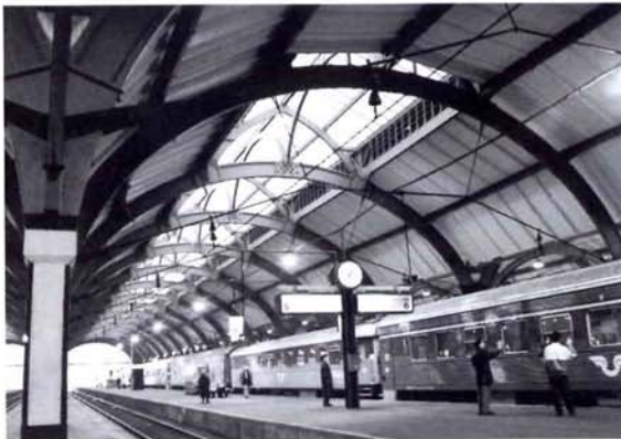
Bahnhofshalle Malmö, 1923 erbaut in Hetzerbauweise, vierschiffige Anlage, Spannweite: 17,9 m, Heutiger Zustand (Foto: C. Magnusson, Malmö)
