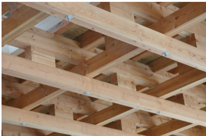
Bild 4. Trägerrostkonstruktion 9 × 9/12 × 12 m aus Duo-balken nach Z.9.1-440
