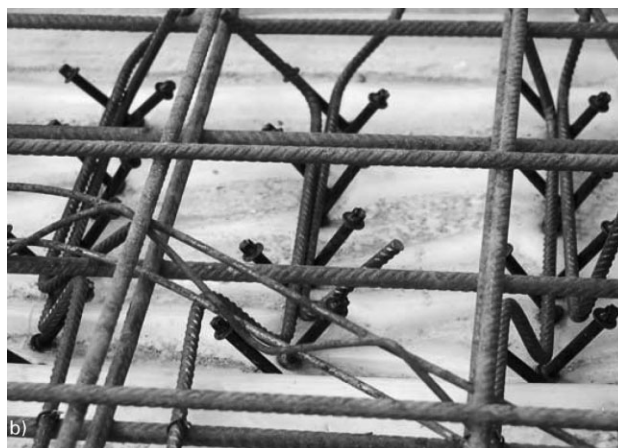
Bild 12. a) Verbundquerschnitt für die Spannweite von 7,1 m; b) Anordnung der Verbundschrauben
