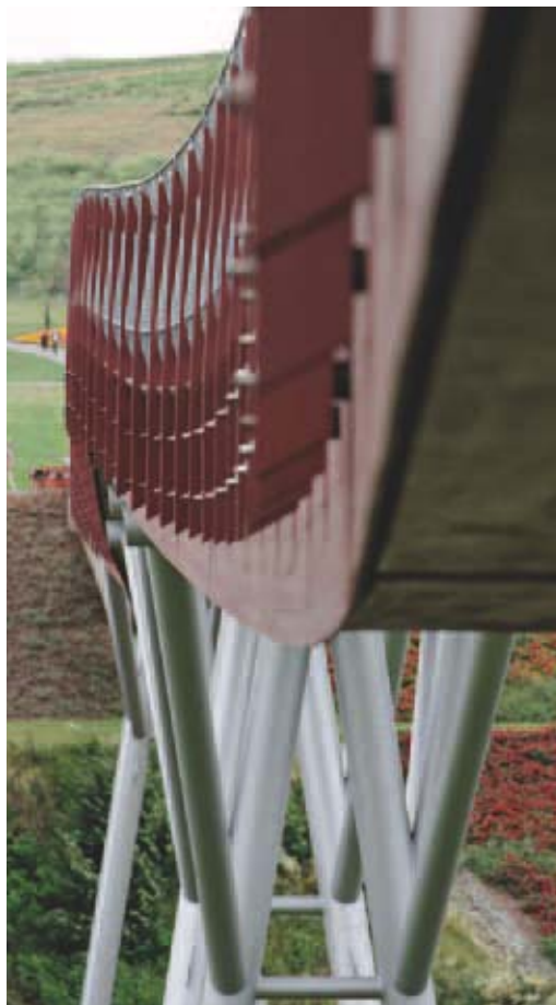
Abbildung 6.14: „Drachenschwanzbrücke“ über das Gessental in Ronneburg
