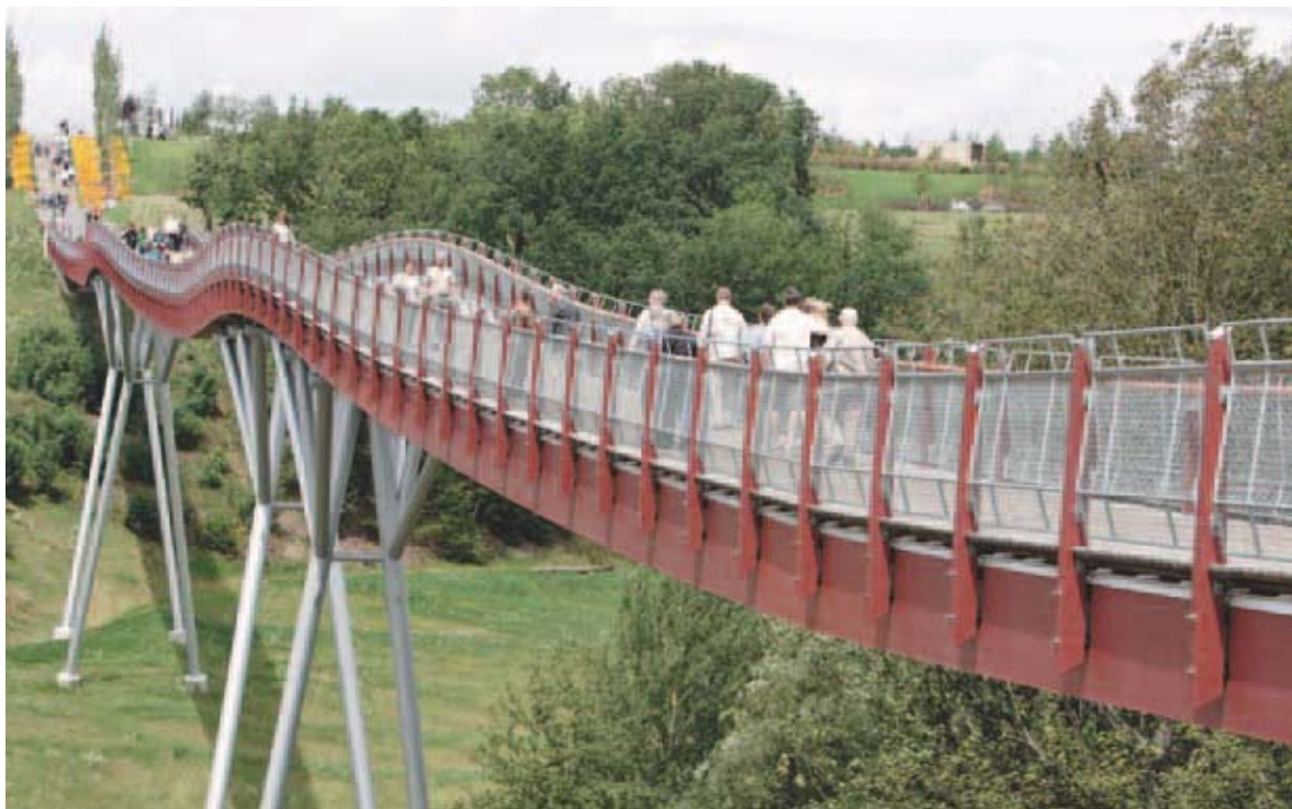
Abbildung 6.15: „Drachenschwanzbrücke“ auf dem Gelände der Bundesgartenschau 2007
