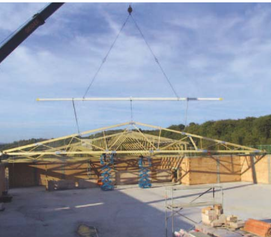
Abbildung. 6.22: Montage eines Fachwerkbinders, Länge 36 m
