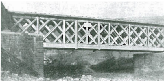
Eisenbahnbrücke über die Pfinz bei Grötzingen, Spannweite: 30 m, 3 genagelte Fachwerkträger im Abstand von 1,0 m bilden die Haupttragkonstruktion Entwurf: Prof. Gaber, Karlsruhe, Ausführung: Zimmermeister Winter, Durmersheim, 1948
