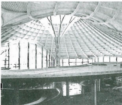
Bild 3.28: Holz-Rippenschale aus Brettschichtholz, gestützt von 5 Baumstützen, überspannt ein Erlebnisbad, Solebad Bad Dürreheim, Ausführung: Fa. Chr. Burgbacher Holzwerk, Trossingen, mit Zimmermeister M. Jörg und G. Arno, 1987 (Bilder aus „bauen mit holz“ [1987] 5)
