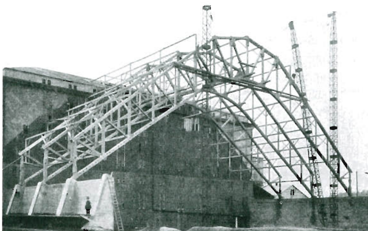
b) Die ersten montierten Binder
