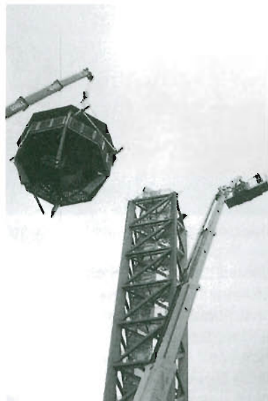
Bild 4.5: Aussichtsturm, Höhe 39,5 m, Ausführung: Fa. Paul Stephan, Gaildorf, 2001 (aus [4.36]) a) CAD-Zeichnung b) Aufsetzen der Kuppel
