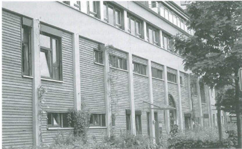
Bild 3.39: Mehrgeschossiges Gebäude in Holz-Rahmen-Bauart (Foto: Qualitätsgemeinschaft Holzbau und Ausbau e. V., Berlin)
