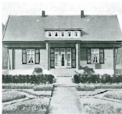
Bild 2.55: Bürgerliches Wohnhaus auf der Dresdner Ausstellung „Jahresschau“, 1925, Architekt: Prof. Albin Müller, Blockbauweise aus genormten Schnittholzbohlen 7x16 cm für Außen- und Innenwände, Produzent: Christoph & Unmack (aus [2.143])
