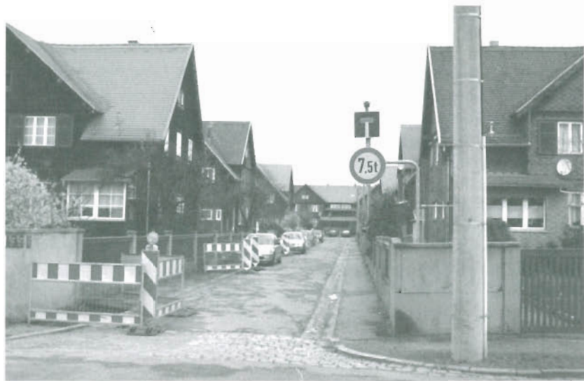
Bild 2.60: Siedlung Dresden Stetzsch, Planung und Ausführung: Höntsch & Co. Niedersiedlitz/Sachsen, 1926/27, Häuser in Blockbauweise, (Foto: Prof. Rug, 2001)
