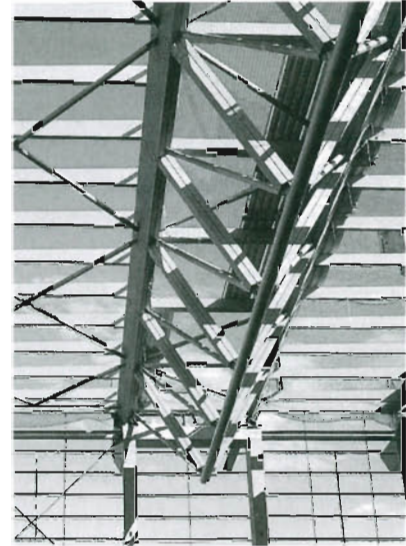
Bild 3.29: Dachkonstruktion für die Messehalle 7a der Messe Nürnberg, Spannweite 85 m, kombiniertes Holz-Stahl-Tragwerk, Fachwerkträger mit zugbeanspruchten Stäben aus Stahl, Ausführung: Fa. Paul Stefan, Gaildorf (aus [2. 227])
