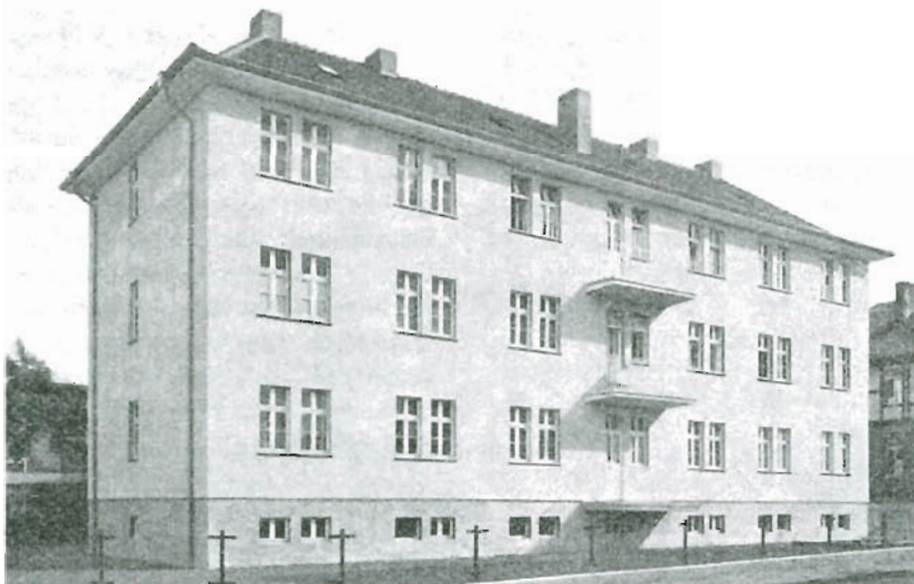
b) Nach Fertigstellung
