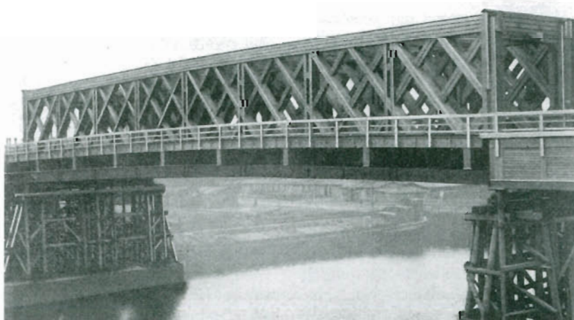
Bild 2.72: Brücke bei Kehl am Rhein, Tragwerk im Bereich der Schifffahrtsöffnung, Spannweite: 50 m, Entwurf: Prof. Gaber, Karlsruhe, 1940 (aus [3.35])
