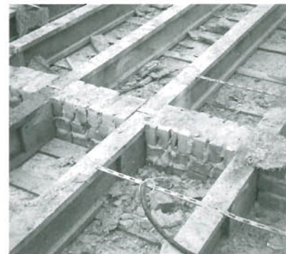
Bild 3.4 Leipziger Decke, I-Querschnitt mit geklebten oder genagelten Gurten, Decke eines Wohnhauses (Baujahr: 1950, vor einer geplanten Aufstockung Foto: Dr. Lißner 2000)
