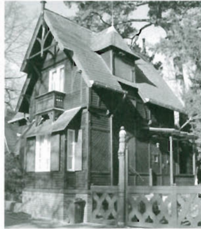
Bild 2.54 : Haus Berlin-Wannsee, Holztafelbau, Architekt: Johannes Lange, Berlin, Wolgaster AG für Holzbearbeitung, 1890 (Foto: Prof. Rug, Zustand 2001)
