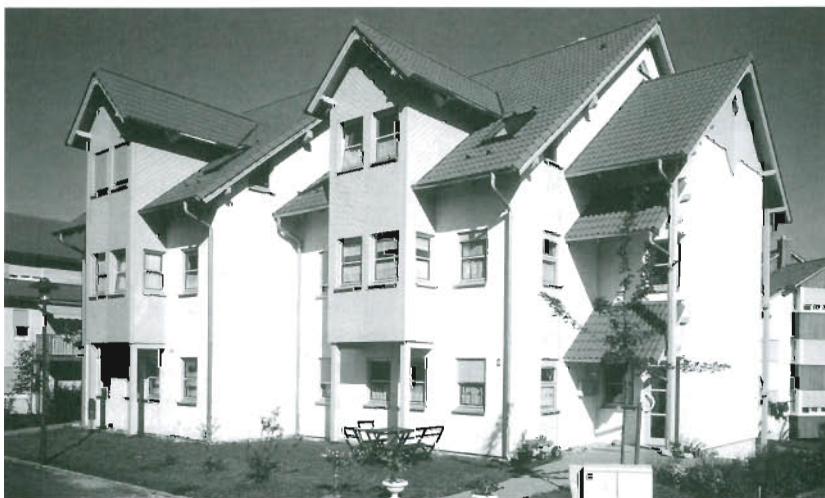
Bild 3.14 Mehrgeschossiges Wohngebäude in Holz-Tafelbauweise (Foto: Pressestelle DFV Deutscher Fertigbauverband e. V., Stuttgart)
