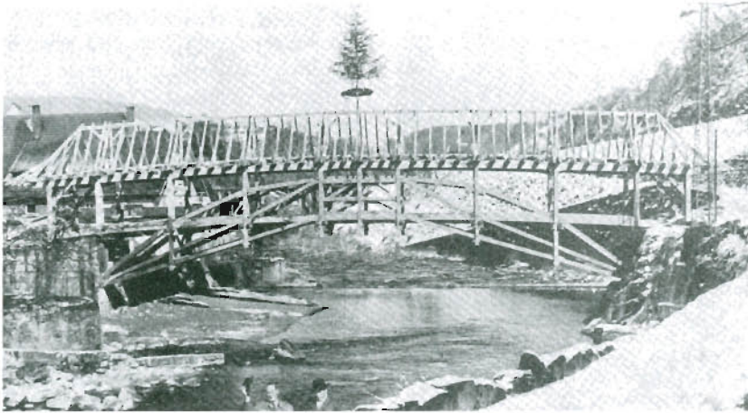
Bild 3.17 b) Brückenneubau ohne Eindeckung und Verschalung
