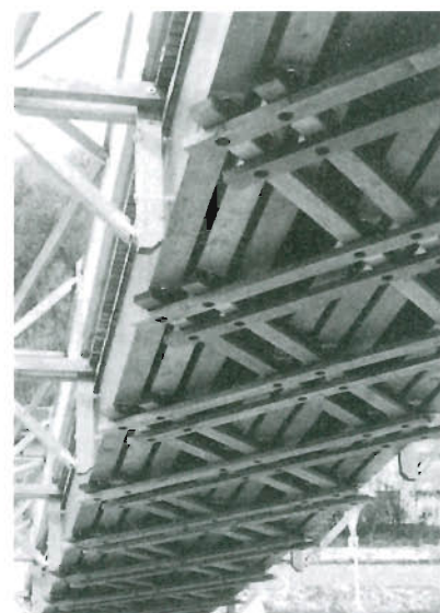
b) Unteransicht mit Aussteifungsverband
