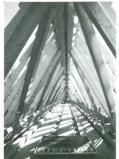
Bild 3.20 Fußgängerbrücke über den Neckar in Remsek, Spannweite 80 m, mit Glaseindeckung, Ausführung: Fa. P. Stephan, Gaildorf, 1988/89 (Bilder aus bauen mit Holz (1988) 12, S. 830) b) Blick in die Brücke
