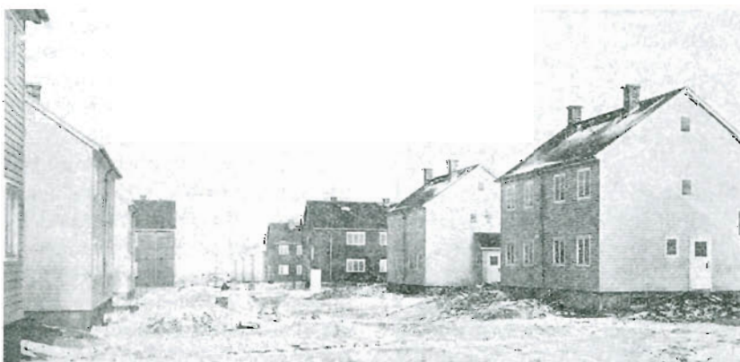
b) Fertigstellung der Gebäude (vergleiche auch Bild 9.2) (aus Deutscher Zimmermeister (1929) 33, S. 444)
