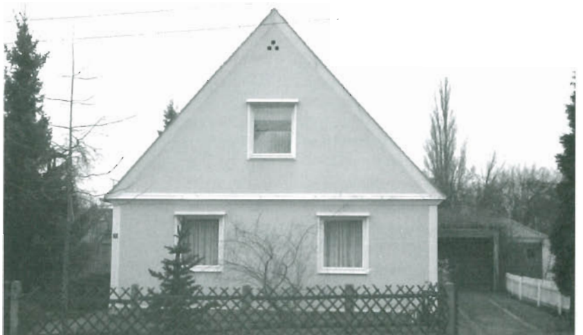
Bild 2.68: Weiterentwickelter Fachwerkbau für Kleine Siedlungshäuser nach dem Patent von Heinrich Tessenow, (Foto eines Siedlungshauses in Dresden Hellerau, erbaut 1911, Prof. Rug, Zustand 2001)
