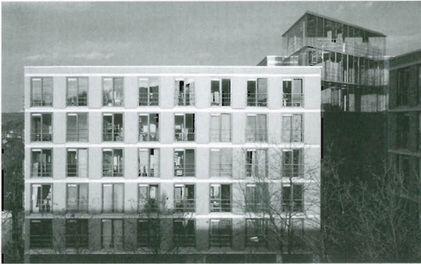
Bild 3.15 Umbau eines Beton-Plattenbaus mit Verbesserung der Wärmedämmung (Passivhausstandard), Studentenwohnheim Wuppertal, Ausführung: Fa. Lux, GmbH, Roth 1999/2000 (aus [4.34])
