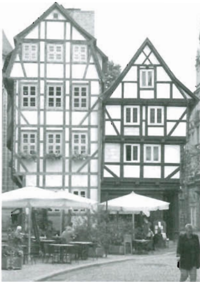
Bild 3.35: Fachgerecht instand gesetzte und sanierte Fachwerkbauten prägen das Stadtbild im historischen Stadtkern a) Quedlinburg (Foto: Prof. Rug)
