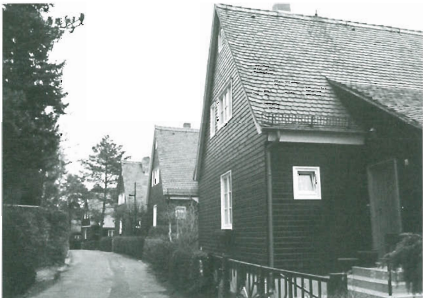
Bild 2.62: Holzhausssiedlung Dresden-Hellerau, Architekten: Wilhelm Kreis und Eugen Schwemmle, „Jalousiebau-Weise“ Ausführung: Deutsche Werkstätten Hellerau, (s. [2.104]), (Foto: Prof. Rug, Zustand 2001)
