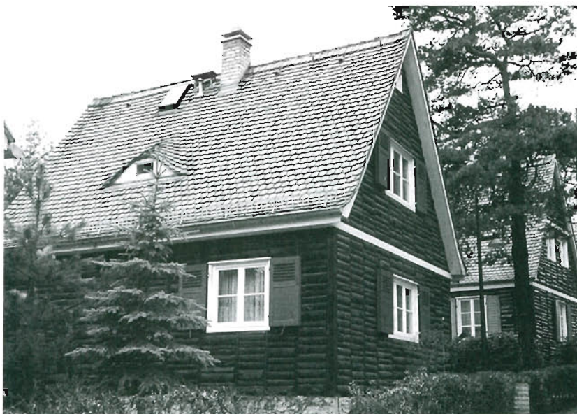
Bild 2.56: Haus in Tafelbauweise, Produzent: Deutsche Werkstätten Hellaerau, 1920 erstmals errichtet, Haus nach gleichem Prinzip 1933 in Dresden-Hellaerau errichtet (Foto: Prof. Rug, Zustand 2001)
