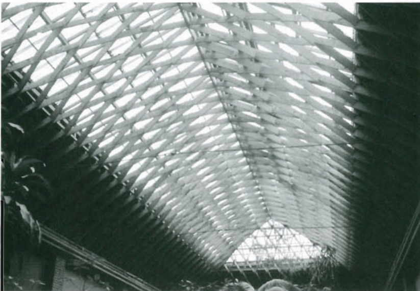
Bild 2.52: Dach des Dickhäuterhauses Zoo Leipzig, 1922 errichtet (Foto: Prof. Rug)
