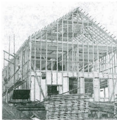
Bild 3.11 Zweigeschossiges Wohnhaus für 12 Familien, Stuttgart, Bauweise: Holz-Gerippebauweise, Foto a) Gerippe mit teilweise Isolierung aus Steinwolle
