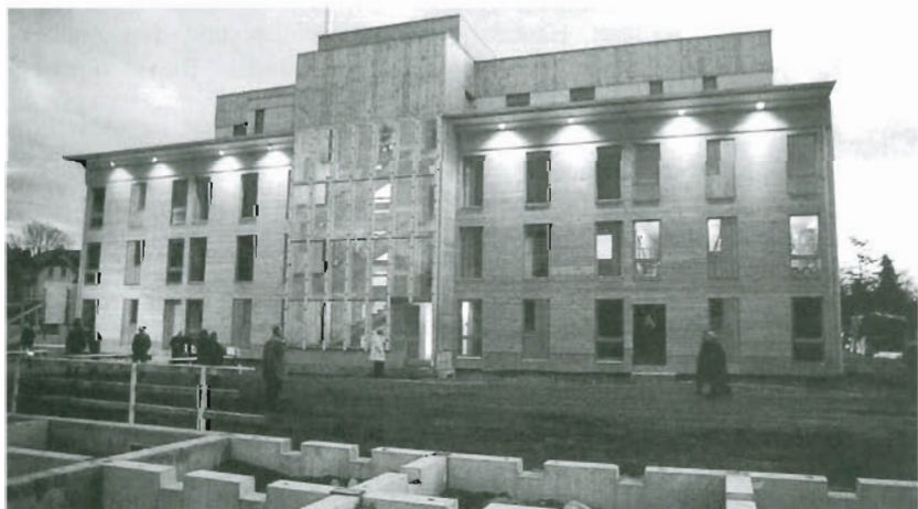
Bild 3.40: Viergeschossiges Wohngebäude aus Ligno-Trend-Elementen, Ausführung: Fa. Holzbau Amann Weilheim-Bannholz, 1999/2000 (aus [3.76])
