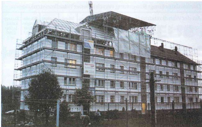
Bestehendes Gebäude (oben) und während der Bauarbeiten
