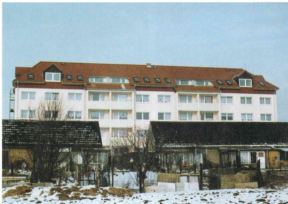
Fertiges Gebäude nach der Aufstockung
