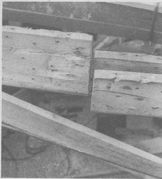
6 Durch kontrolliertes Anziehen der Pressen wieder auseinandergedrückte Obergurte um den meßtechnisch nachgewiesenen deformierten Weg von 15 mm
