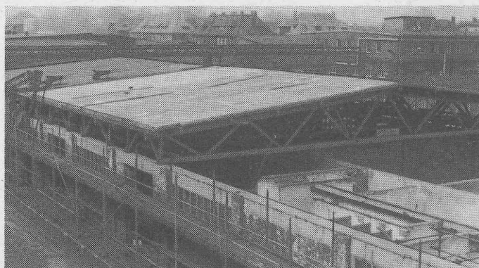
10 Bindersegmente nach dem Vershub
