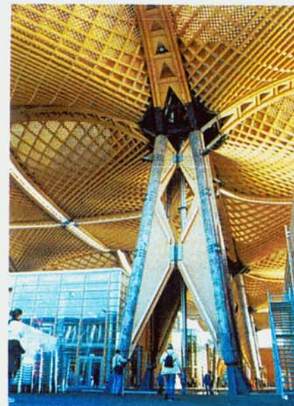
Abb. 1: Das EXPO-Dach in Hannover - eine Brett-Rippenbauweise aus zehn quadratischen Schirmen mit einer Seitenlänge von 39 Metern - überdachte bei einer Höhe von 26 Metern eine Fläche von 16.000 Quadratmetern.
