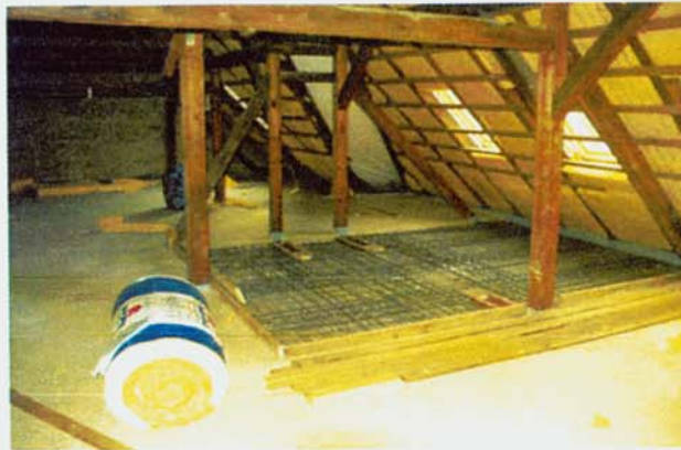
Abb. 4: Herstellung einer Holzbeton-Verbund-Decke im Dachgeschoß eines Altbaus.
