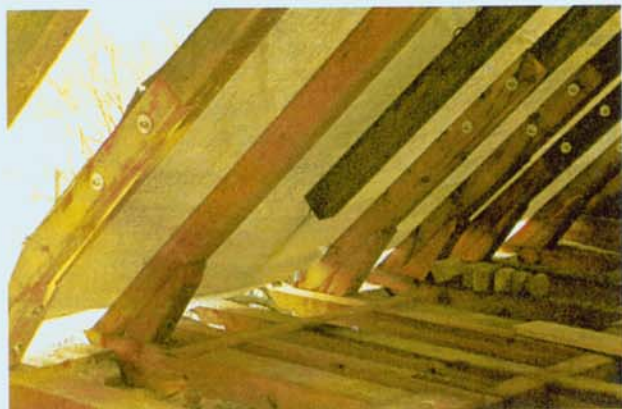
Abb 3: Material- und denkmalgerechte Instandsetzung eines zweihundertjährigen Dachstuhls, einschließlich der Instandsetzung der Deckenbalken
