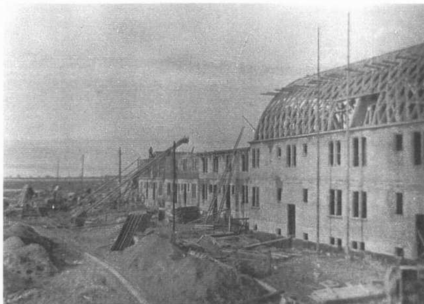
Bild 10. Siedlung im Bau, Siegfriedstraße, Merseburg (1928) Fig. 10. Housing estate under construction, Siegfriedstrasse, Merseburg (1928)
