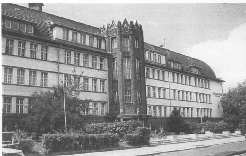
Bild 13. Schule, heute Dürer-Schule, Dürerstraße, Merseburg (erbaut 1928) Fig. 13. School (today named Dürer-Schule) in Dürerstrasse, Merseburg (built in 1928)
