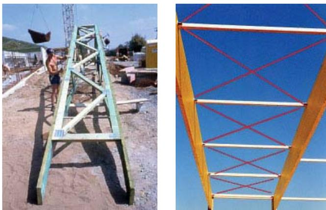
Bild 65. Verbände, links: druck- und zugfeste Diagonalen, rechts: mit druckschlaffen Diagonalen
