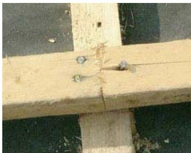
Bild 44. Stoß der Dachlatten auf einer Konterlattung. Negativbeispiel, Randabstand der Nägel nicht eingehalten, rechte Latte gespalten
