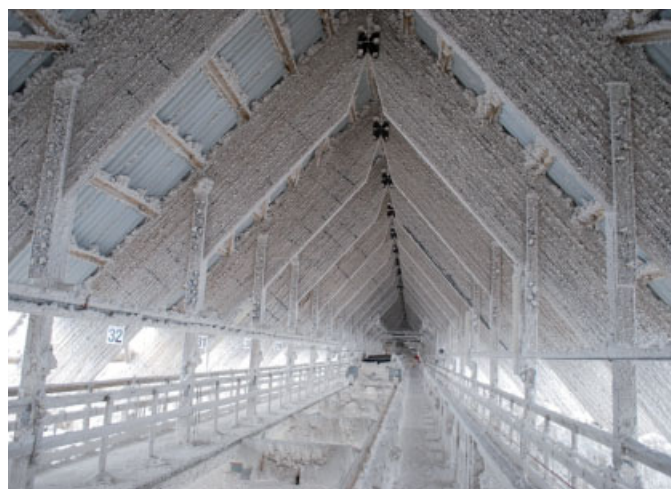
Bild 1. Speicher für Rohsalze, Bandzuführung im Firstbereich einer 36 m weit spannenden Salzlagerhalle aus Brettschichtholz
