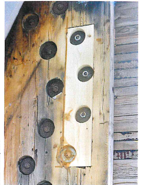
(9) Passstück aus neuem Bauholz
