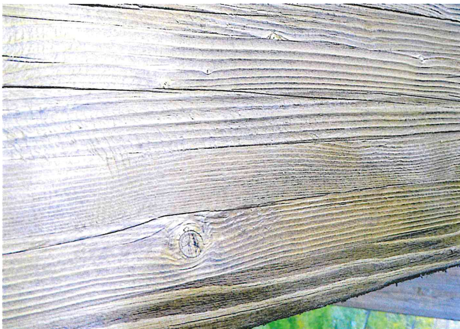
(1) Schwindrisse in einem frei bewitterten Brettschichtholzbauteil
